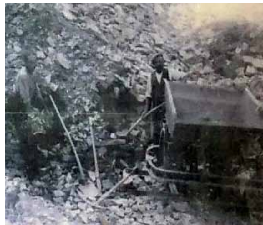
Eine Lore wird mit Steinabraum beladen (Goßmannsdorf).
